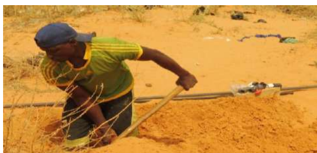
Figure 12 : un plombier en train d'installer un robinet pour un chantier de construction de maison
