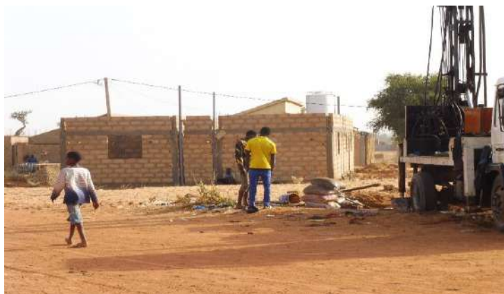
Figure 6 : un forage en construction sur un chantier à Saguia, janvier 2021
