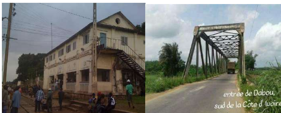
Image 7 : La Gare ferroviaire d'Agboville
