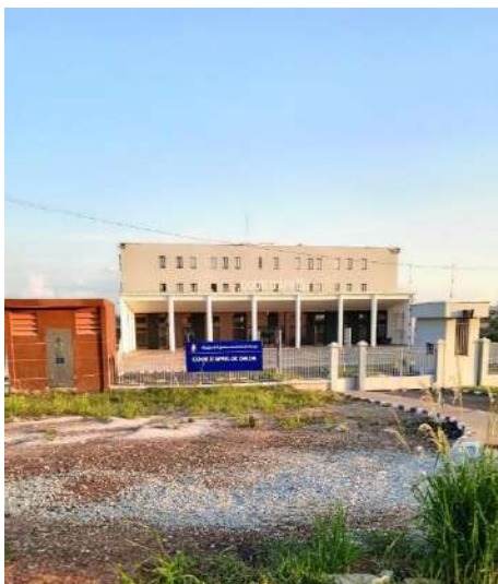
Figure 2 : nouvelle Cour d'appel de Daloa
