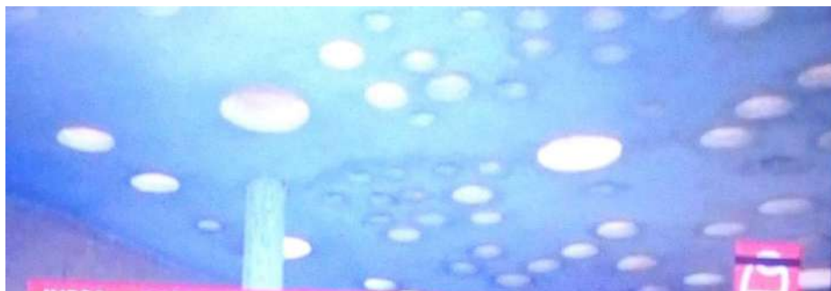
Fig 4 : Système d'éclairage naturel de l'École de Gando
