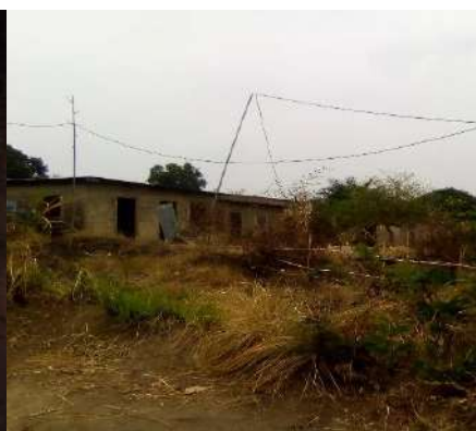
Photo n°2 : Utilisation des poteaux hors normes (zone 8). Prise de vue G. D. Kelet Ntombo, 2021
