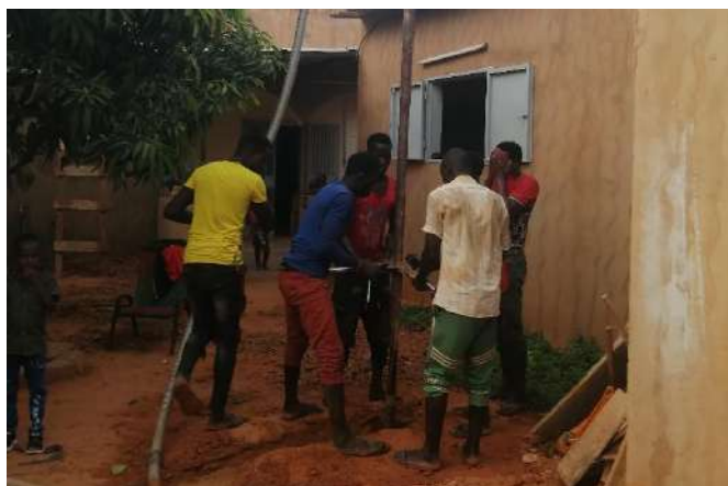
Figure 7 : fonçage manuel-artisanal d'un forage à Saguia, mars 2022
